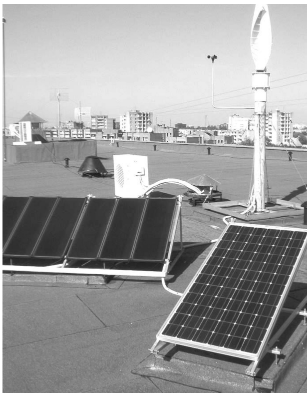
3 pav. Realios KTU AŠETC komplektuojamos hibridinės saulės-vėjo mikroelektrinės nuotrauka
