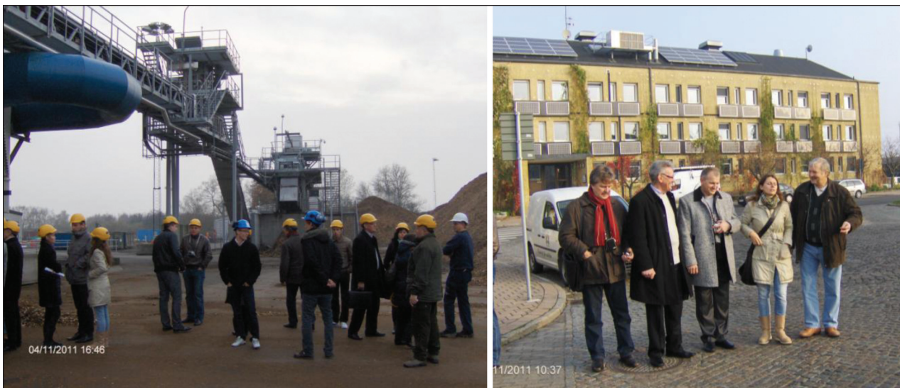
Ljungby biomasės kogeneracinė jėgainė
