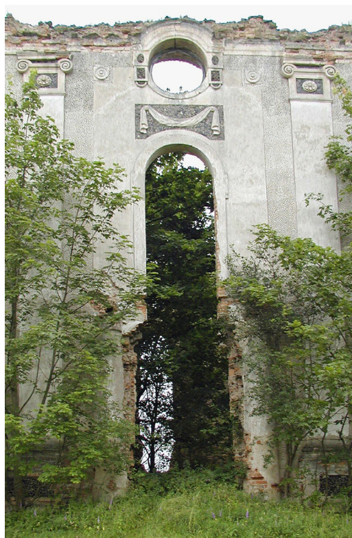
Il. 3. Kaplica w Jablonowie, fragment elewacji pn.-wsch. z portalem. Fot. A. Oleńska, 2008
